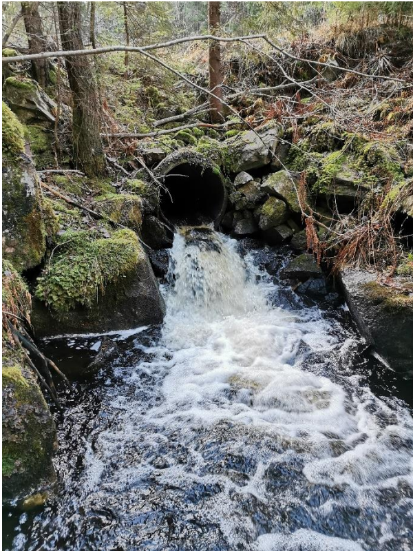
Figur A6: Kulvert mellom stasjon B5 og B6.
