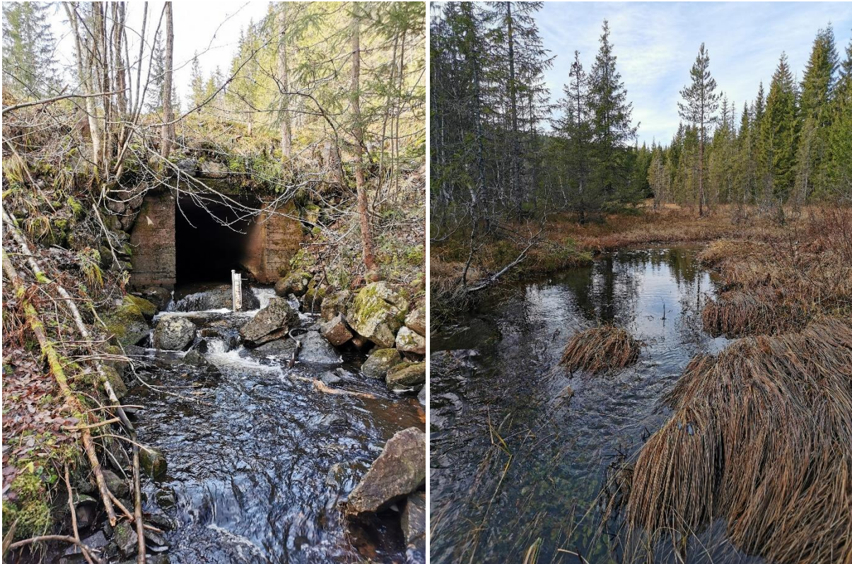
Figur A7 (t.h.): Bekken renner under betongbru mellom stasjon C3 og C4.
